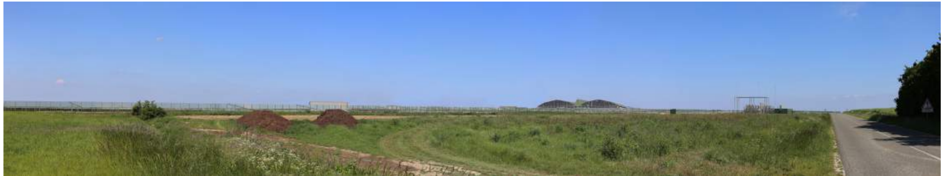
Point de vue n°2 - Vue depuis la route départementale n°31 au sud du projet donnant sur le poste de transformation 1-5
